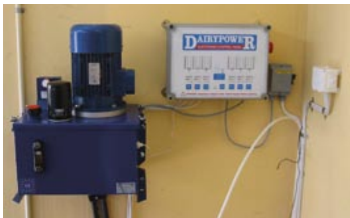
Hydraulisk drivenhet med styrskåp för upp till 6 skrapgångar.
