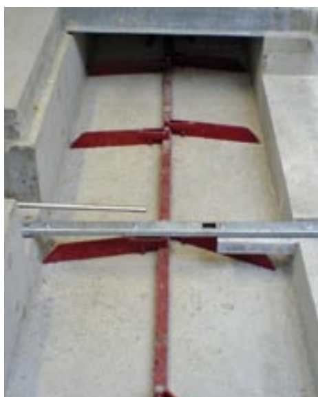
UNP-med med rostfria tappar. Enkel eller dubbelfällande skrapor
